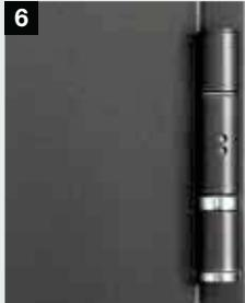
Серийные петли, установленные в шарикоподшипниках
