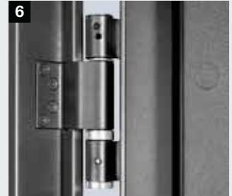
Простая замена петельных роликов на дверном полотне (на рис.: многофункциональная дверь OD)
